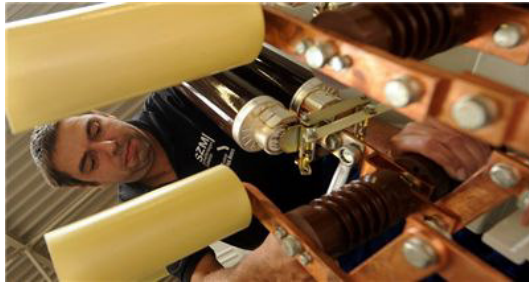
Ronny Rupalla montiert sogenannte Stützer. Sie sind für Mittelspannungsschaltanlagen in Saudi-Arabien bestimmt. Nun peilt sein Arbeitgeber SZM unter anderem den kubanischen Markt an.
